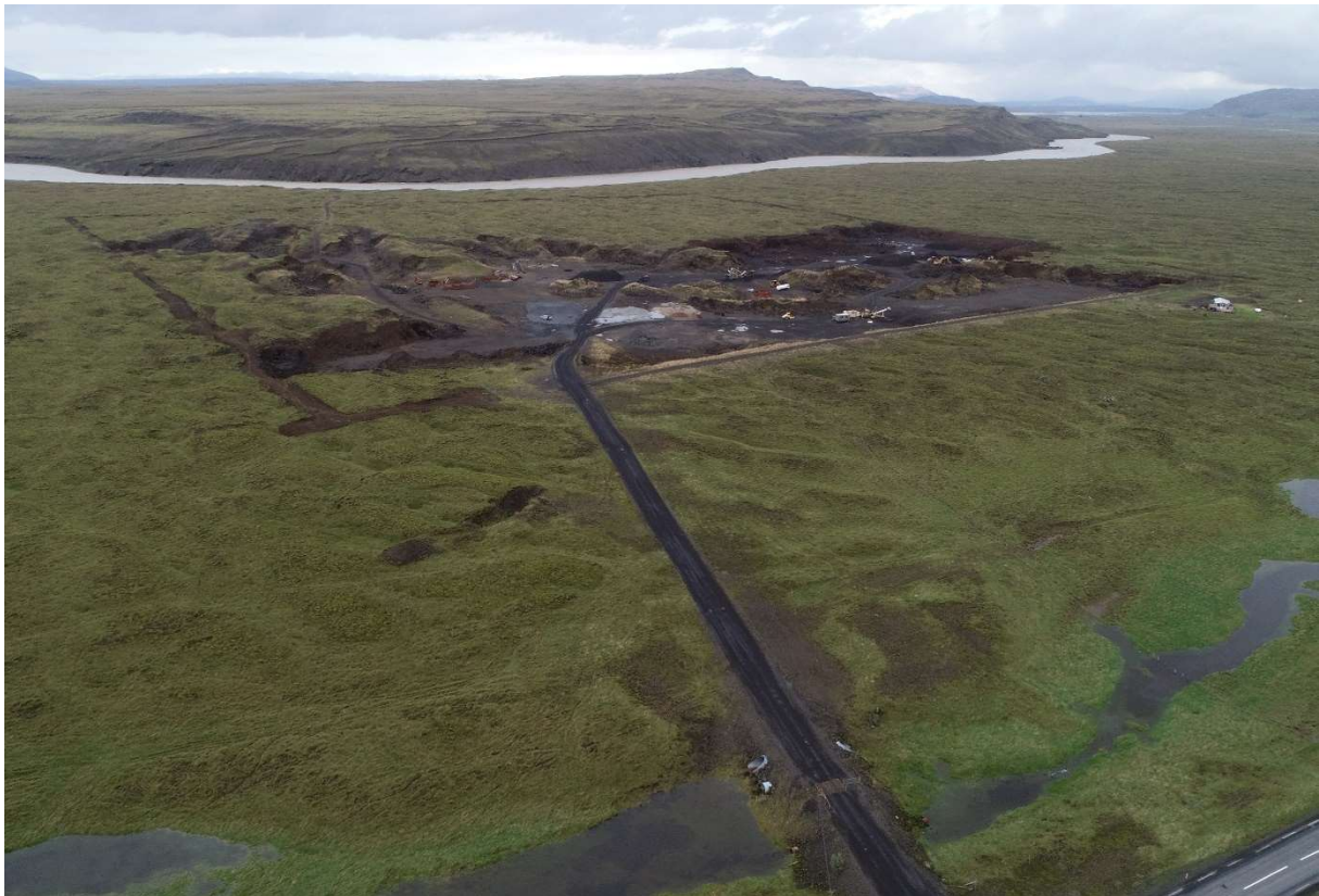
MYND 4.5 Horft yfir námuna og næsta nágrenni.
